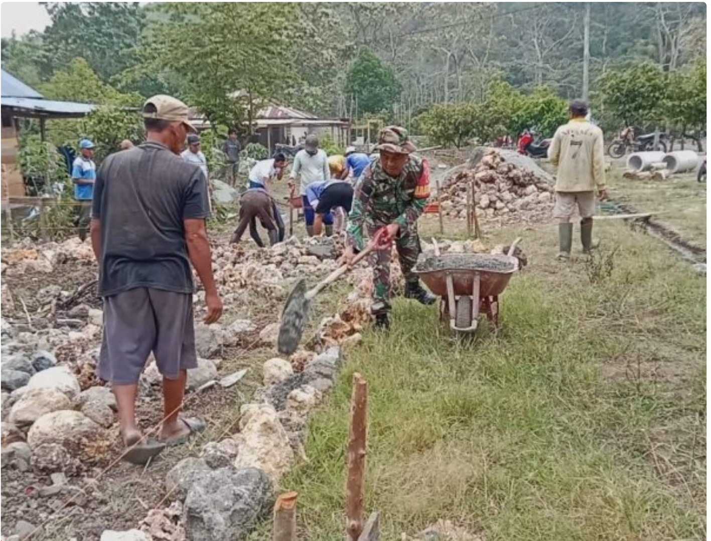
Gotong royong bangun pondasi rumah warga
